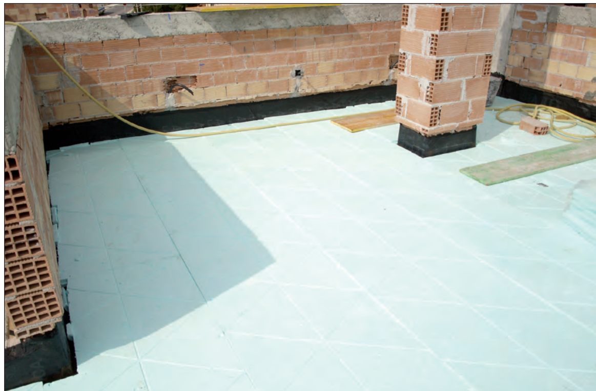
EPS-h en una cubierta plana invertida.
